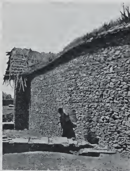
Abb. 13. Schichtung und Abdeckung des Mauerwerks.
